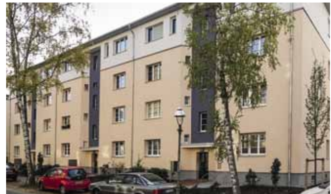
A3 (oben) Ansicht vor der Sanierung. A4 (unten) Ansicht nach der Sanierung.
